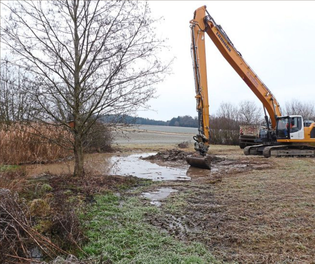
Der Langarmbagger half dabei, die Teiche von Schlamm und übermäßigem Bewuchs zu befreien.
