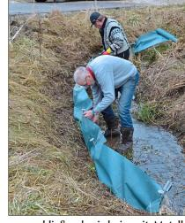
... anschließend wird sie mit Metallpfeilern befestigt und dichtgemacht.
