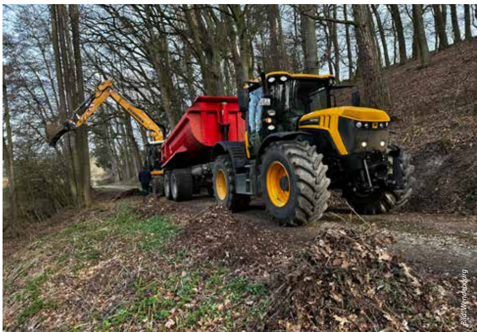
Mit professionellem Gerät wurde der Unrat und die Gartenabfälle von der Böschung abgezogen und abgefahren.
