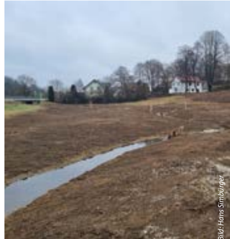
Südlich von Hohenthann kann der Goldbach wieder mäandrieren und über die Ufer treten.
