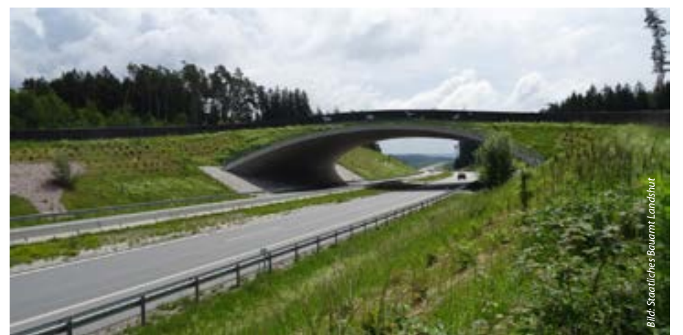
Die Grünbrücke am Galgenberg verbindet die Lebensräume, die von der B15 zerschnitten werden.
